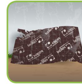
После демонтажа опалубки осмотрите фанеру. Удалите остатки бетона. Не используйте сильно деформированные листы для дальнейших заливок. Если повреждения незначительны, используйте листы на доборы.
