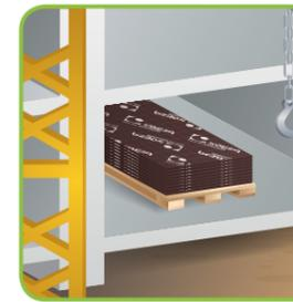
Фанеру, предназначенную для монтажа опалубки следующих этажей, аккуратно сложите в стопу для дальнейшего перемещения с помощью крана.
