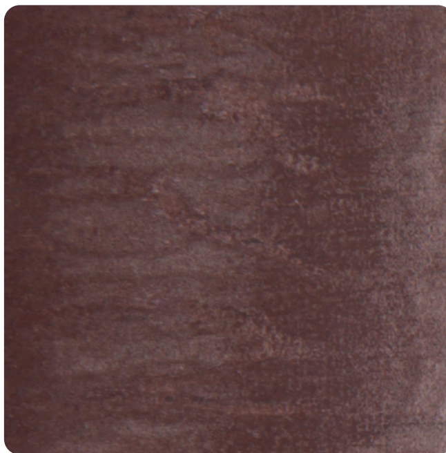
Температурные разводы без нарушения целостности облицовочного покрытия
